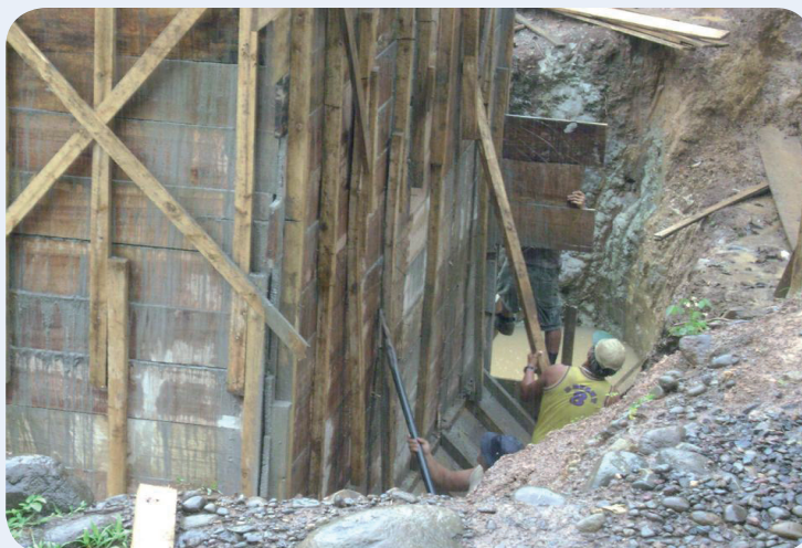
Construcción de puente en Santa Rosa de Pocosol
